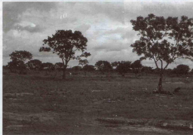
Campus UPSA. Terrero. Obras recién iniciadas. Febrero 1992
